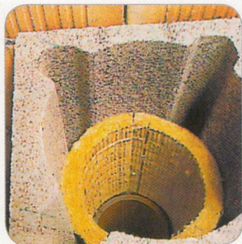
4.2 Mehajlítjuk és behelyezzük a szigetelőlapot.
